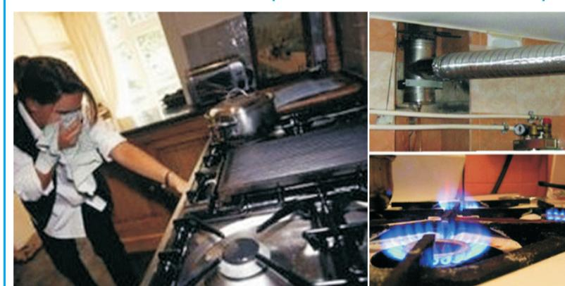
və orada olan ventilyasiya sistemi quraşdırılmayıbsa, böyük ölçüdə qaz pilətisi qoymaq olmaz. Eyni qayda hamam otağına da aiddir. Kiçik hamam otağına böyük ölçülü suqızdırıcıının qoyması təhlükəlidir. Cihazın borusunun çıxış yeri olmalıdır. Zəruri ventilyasiya sistemi yoxdursa, hamam otağının qapısının aşağı hissəsində hava oynaması üçün dəliklər açılmalıdır və ya qapalı mühitdə qaz yandırarkən nəfəsliliklər açıq olmalıdır.
